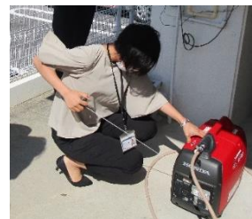
ガス発電機作動テストの様子
