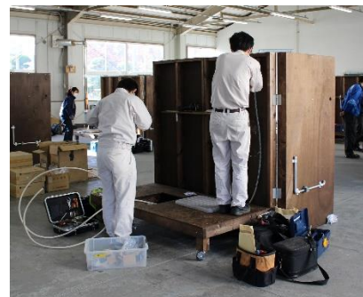
▲配管用フレキ管講習 実習の様子
